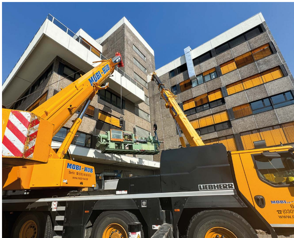
MIT ZWEI KRÄNEN MUSSTEN DIE MASCHINEN AUS DEM FENSTER GЕHOBEN WERDEN
